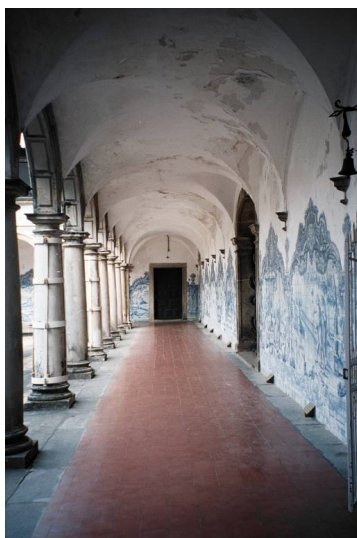
Figura 6. Galeria do claustro - Pav. Térreo
